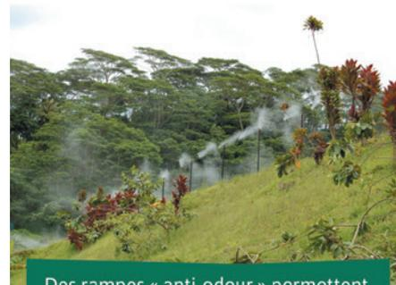
Des rampes « anti-odeur » permettent de pulvériser un produit contre les mauvaises odeurs. Il n'est pas toxique pour l'homme, ni pour la faune et la flore.
