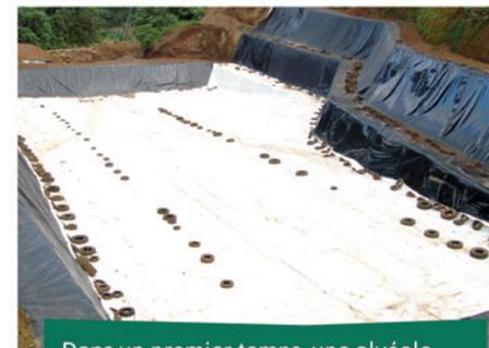
Dans un premier temps, une alvéole rectangulaire de 6.000 à 10.000 m2 de base est réalisée. Puis, chaque casier est équipé d'une géomembrane étanche et d'un système de récupération du lixiviat.
